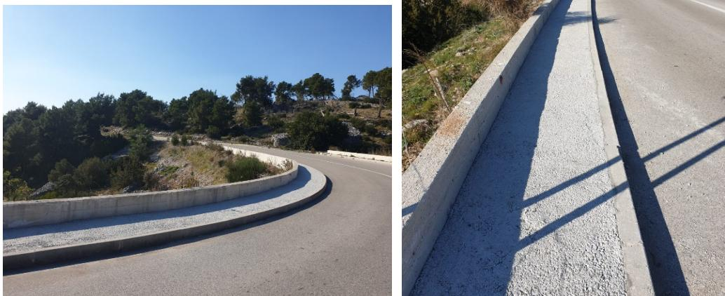
Radove je izvodila tvrtka Breznički d.o.o. iz Zagreba. U ovoj godini planirana je izgradnja Dosićina II. Radovi predviđaju proširenje postojeće ulice u dužini od cca 180 metara sa spojem na obilaznicu te polaganje betonskog ili asfaltinskog zastora.
