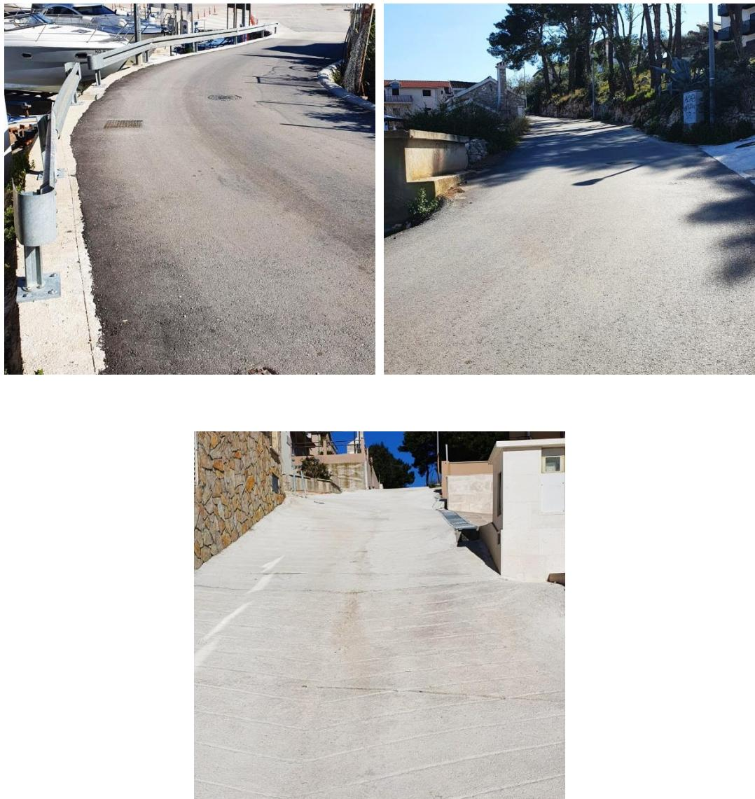
Za vrijeme izvođenja radova polaganja kanalizacijske i vodoopskrbne cijevi u okviru realizacije projekta izgradnje vodoopskrbnog sustava Makarac, Općina Milna je finansirala proširenje dijela kolnika nerazvrstane ceste M28 (Ulica Brdo II) te polaganje novog asfaltног kolnika i branika na dijelu ceste iznad područja ACI marine Milna.
