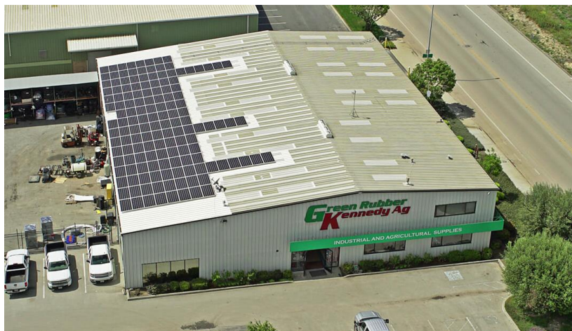
Slika 32. Primjer sunčane elektrane na krovu proizvodno-poslovne zgrade
