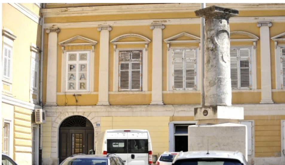
Slika 55. Primjer neugledne instalacije klima jedinice na fasadi javne zgrade
