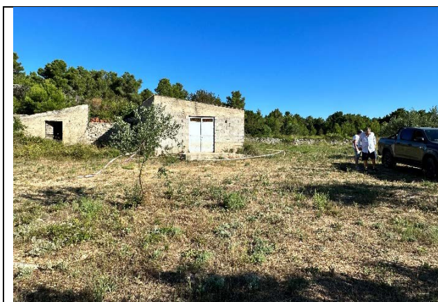
Slika 05: Pogled na postojeće pomoćne zgrade uz jugoistočni rub obuhvata, 2023.
